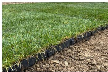
Commencez la pose à une extrémité du chantier en positionnant le système de fixation dans le sens de l'avancement. Clipsez les dalles les unes avec les autres grâce à leurs structures. Découvrez la méthode de pose en vidéo : <https://www.youtube.com/watch?v=WR-q15rMyc4&t=1s>
